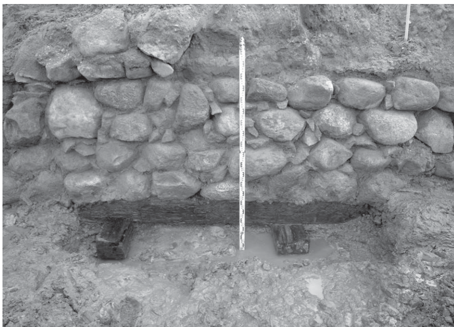
4 pav. Rostverkas po Šv. Jono bažnyčios pamatais (G. Zabielos nuotr. 33 )
