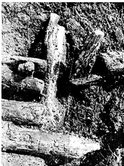
**Abb. 2.** Eckverbindung eines Blockbaus in der Inselsiedlung Ušuri.
