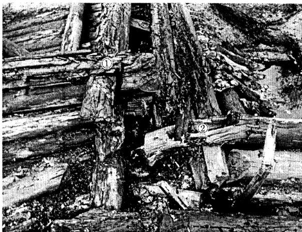
**Abb. 5.** Typen der Eckverbindung an den Gebäuden der Inselsiedlung Āraiši. 1 – Verkämmung; 2 – Jochverbindung.
